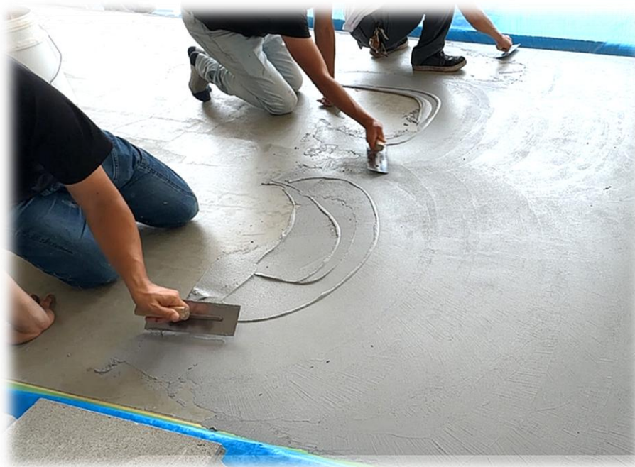
下塗り作業(不陸調整作業含む)
