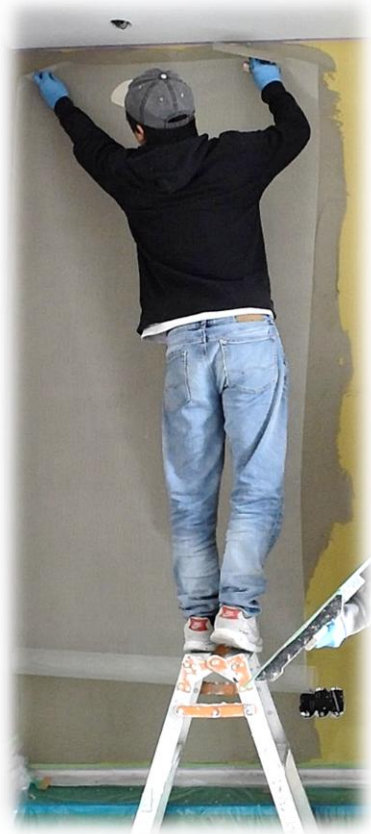
ネット伏せ込み(下塗り時)
